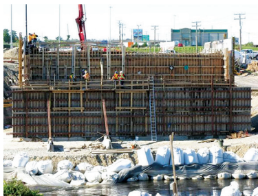
Batardeau en sacs de sable et géotextile
