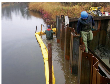
Batardeau en palplanches
