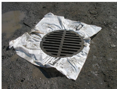
Géotextile installé sous le couvercle du puisard
