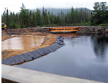
Batardeau en blocs de béton et géotextile
