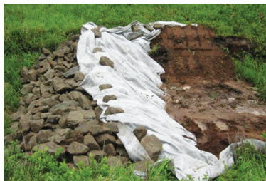
Trappe à sédiments avec berme étanche
