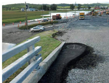
Détournement temporaire des eaux
