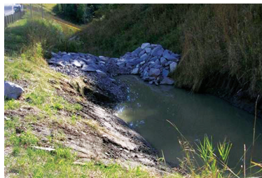
Trappe à sédiments avec berme filtrante
