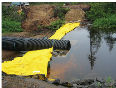
Batardeau en sacs de sable et géotextile
