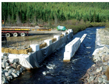
Batardeau en blocs de béton et géotextile
