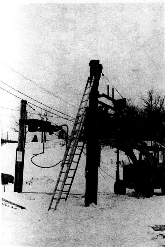
Des ouvriers dirigés par M. Maurice Laporte sont à installer un deuxième monte-pente au centre d'hiver familial d'Ailleboust.
