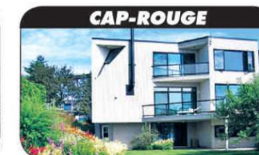
CAP-ROUGE Vue imprenable et accès au fleuve, 4255, France-Roy, superbe résidence avec fenestration abondante, garage double excavé, foyer, 4 chambres. Produit très rare!
