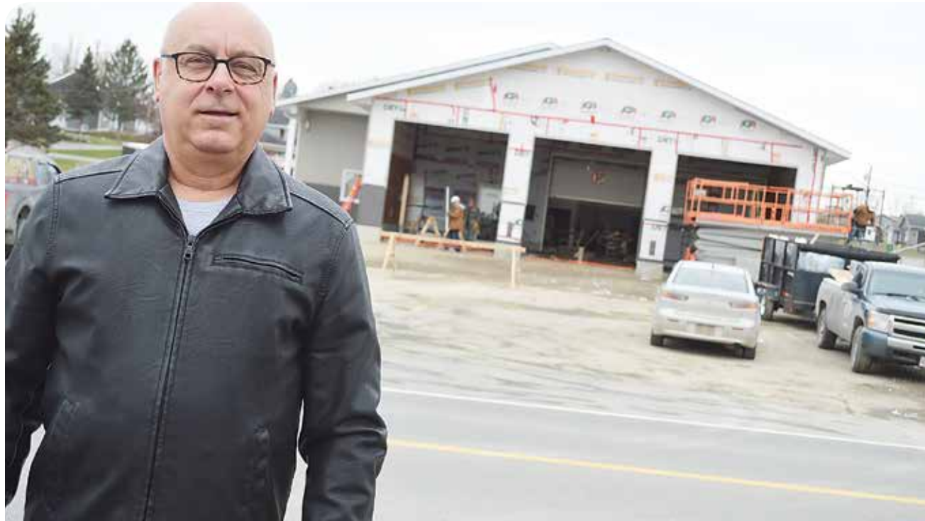
Sur la photo, on peut apercevoir le maire de Drummond, France Roussel, devant la caserne d'incendie où des travaux sont en cours. Photo: Christine Thériault/Info Weekend
