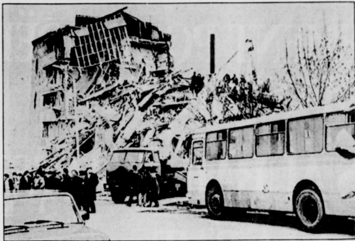
A Spitak, l'une des villes plus dévastées de l'Arménie soviétique, la plupart des édifices de plusieurs étages se sont écroulés.
