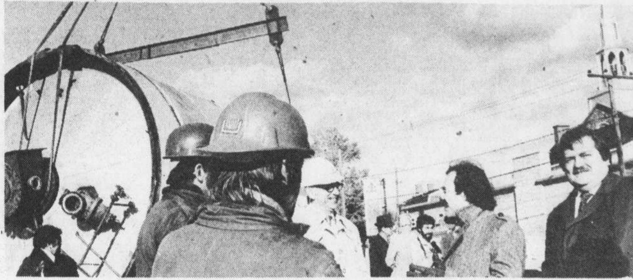
Douze chaudières à cuire, d'un poids de 32 tonnes chacune et d'une hauteur de 25 pieds avec diamètre de 17", ont été livrées hier matin à la Raffinerie de sucre du Québec, à Mont-Saint-Hilaire. M. Jean Garon (à droite), ministre de l'Agriculture, était sur les lieux pour les accueillir, accompagné de MM. André Marier (à gauche), président de la Raffinerie, et Jean-Pierre Charbonneau, député de Verchères. (Photo Jacques Grenier)
