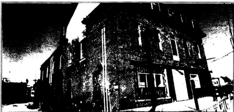
Les travaux de démolition devaient débiter cette semaine.
