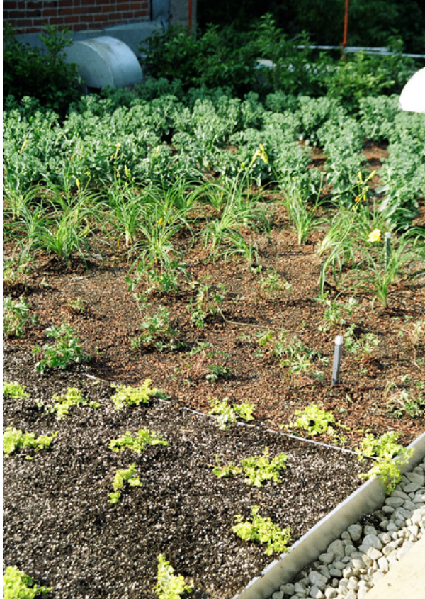
Figure 1.4 Les deux types de substrat du toit du CÉUM.
