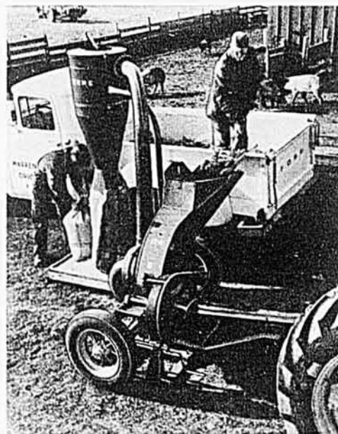
Vous pouvez broyer 5600 livres d'épis de maïs à l'heure, avec ce moulin à marteaux mobile John Deere de 10 po. à prise de force.
