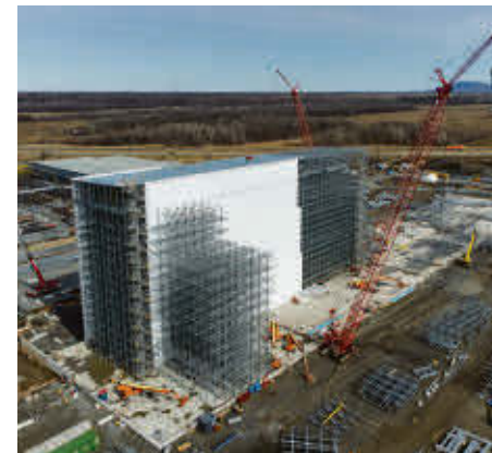
Environ une année a été nécessaire aux monteurs d'aciers et aux différents travailleurs de Construction Sorel pour ériger l'immense structure. Photo Pascal Gagnon
