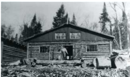
Chantier de la MacLaren, camp no. 3. Collection Gertrude Constantineau.
