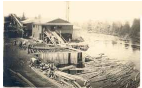
Moulin à scie et cour à bois de Samuel Ouellette en 1910. Entrepreneur actif, il construira l'évêché, l'Académie du Sacré-Cœur, le premier séminaire, la cathédrale. Il achètera une manufacture de portes et chassis et sera actionnaire de la Fonderie Mont-Laurier et de la Laurentian Power & Water. Il est, à cette époque, le plus gros employeur de la région.
