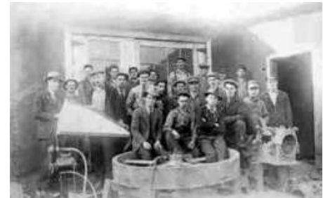
Des employés de la Fonderie
