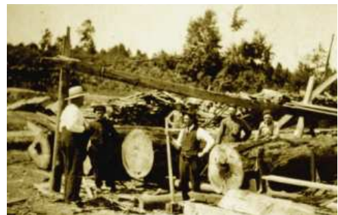
Moulin à scie portatif de Godfroy Lamarche, photographié sur la rue du Portage, à l'occasion du sciage de billots de pins de Wilfrid Touchette. Les planches ont servi à la construction de sa maison et du bureau de poste situés sur la rue de la Madone. De g. à dr. Wilfrid Touchette, Eugène Lamarche, Léo Lamarche, Godfroy Lamarche (au centre, avec un outil en bois à la main), Noël Lamarche et Georges-Émile Lamarche.
