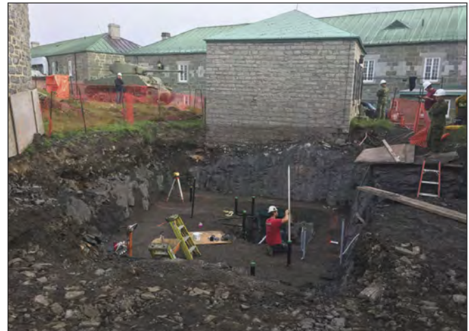
Travaux d'excavation en cours pour aménager la salle mécanique qui régularisera la température ambiante de l'APF.
