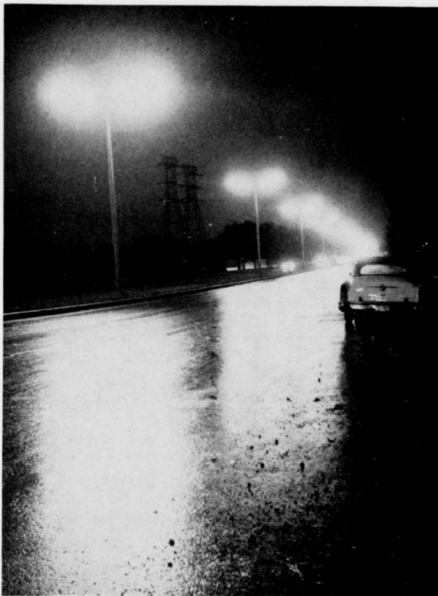
Fig. 7 — Ci-dessus, rue éclairée par lanternes fluorescentes de 6 pieds de longueur (boulevard Pie IX, près Mason, Montréal). Comme dans la figure 4, la rue est claire là où la lumière est réfléchiée vers sol, mais les plages de lumière sont larges et se touchent par emploi de sources non-punctuelles et non-focalisées.
