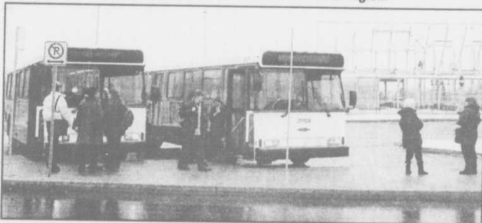
Les nouveaux autobus sont en service depuis le 1er janvier. À l'arrière plan, on aperçoit la structure du futur terminus actuellement en construction. (photo : Philippe Pilette)
