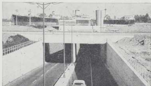
TUNNEL DE L'ÎLE DEAS, VANCOUVER
