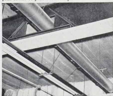
1,800 tonnes de charpente d'acier, fabriquée et érigée par la Dominion Bridge, Winnipeg. La majeure partie de cette charpente est du type "rigide".
