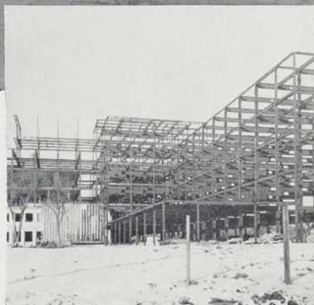
1,800 tonnes de charpente d'acier, fabriquée et érigée par la Dominion Bridge, Winnipeg. La majeure partie de cette charpente est du type "rigide".
