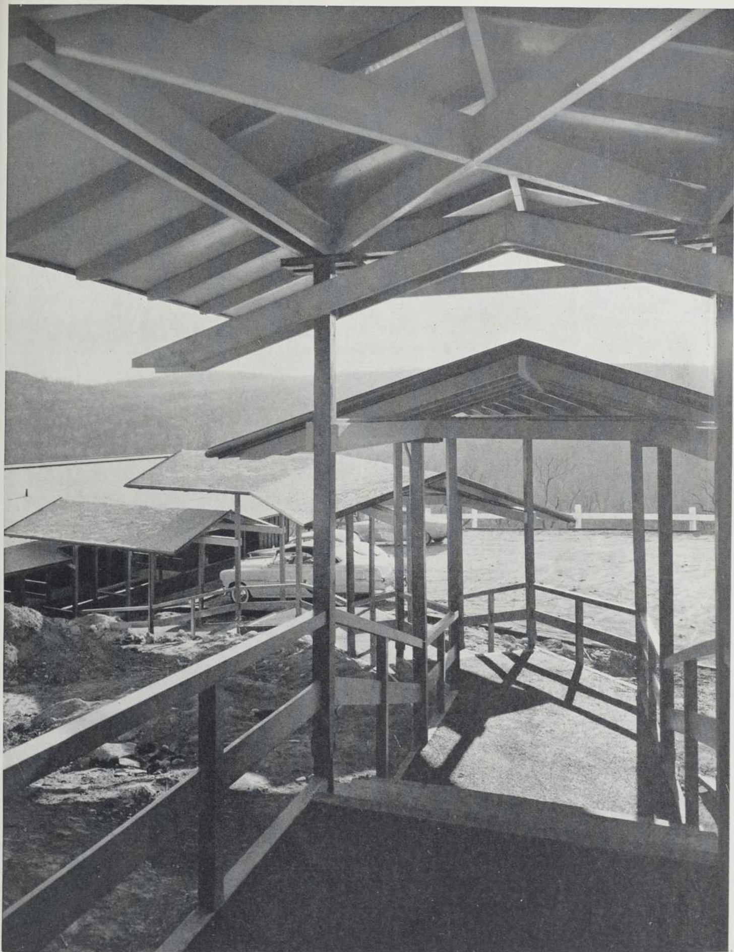
Le bois à coupe droite forme la structure apparente du "Motel on the Mountain". Les architectes l'ont choisi à cause de la facilité avec laquelle il se travaille, et de l'harmonie naturelle qui s'établit entre le bois et le paysage.
