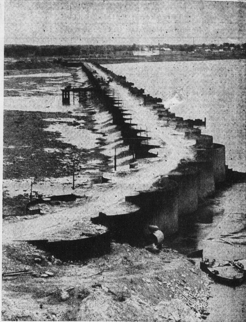
UN OBSTACLE AUX FLOTS DU ST-LAURENT. — Comme un véritable bras d'acier, cette charpente de 4,500 pieds de long fait obstacle aux flots du St-Laurent, entre la terre canadienne et le sol de l'île Barnhart. Ce pont temporaire permet de travailler à sec à la construction des deux usines hydro-électriques. Il est possible que la canalisation du St-Laurent amène la reproduction de ce bras d'acier dans la région de Montréal. (Photo de l'Hydro ontarienne)
