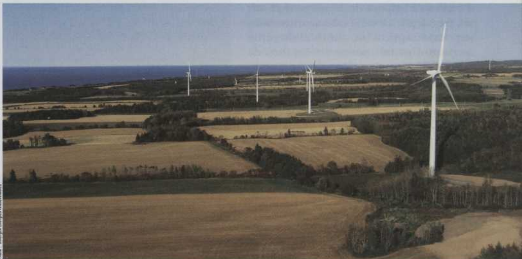
Planter des éoliennes dans un milieu habité requiert du doigté. À Baie-des-Sables, en Gaspésie, ça a donné ceci.
