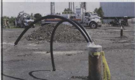
Un tuyau pour l'arrivée et un autre pour le retour du fluide. Cette structure disparaîtra bientôt à 6 pieds sous terre.
