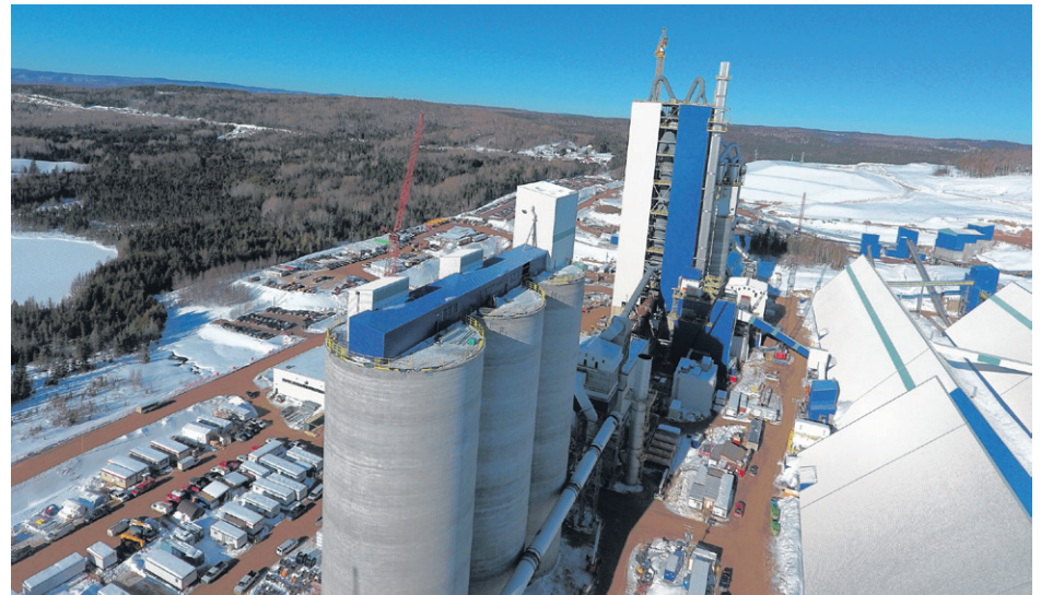
Les concasseurs en construction l'automne dernier. (Photo gracieuseté Ciment McInnis)
