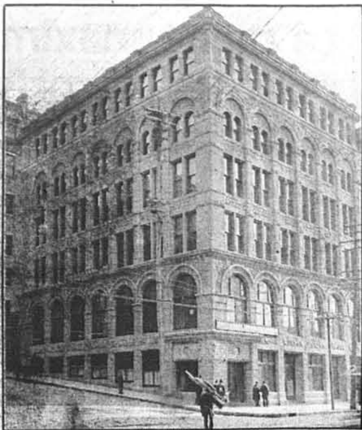
CI-dessus, l'édifice de la Montreal Street Railway au début du XXe siècle. À noter plus particulièrement, la porte d'entrée, à gauche de la façade. À droite, la façade de l'édifice telle qu'elle apparaît actuellement, avec ses deux étages additionnels.
