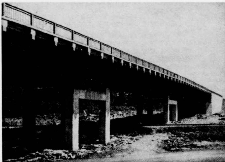
Structure du viaduc au-dessus des voies du C.N.R. sur l'Autoroute Montréal-Laurentides à St-Jérôme
