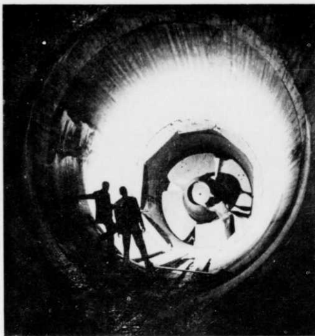
Fig. 5 — Groupe bulbe de Beaumont Montoux. 12,000 hp. sous 41 pieds. Vue d'aval.
