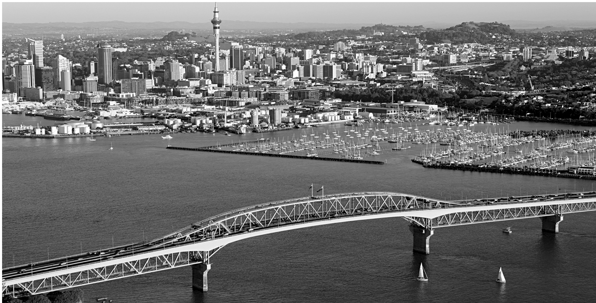
Le pont Akl Harbour d'Auckland.
