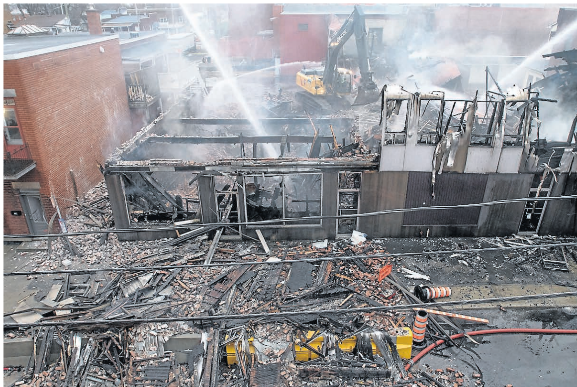
Le bâtiment avait commencé à être converti en logements. — PHOTO: STÉPHANE LESSARD
