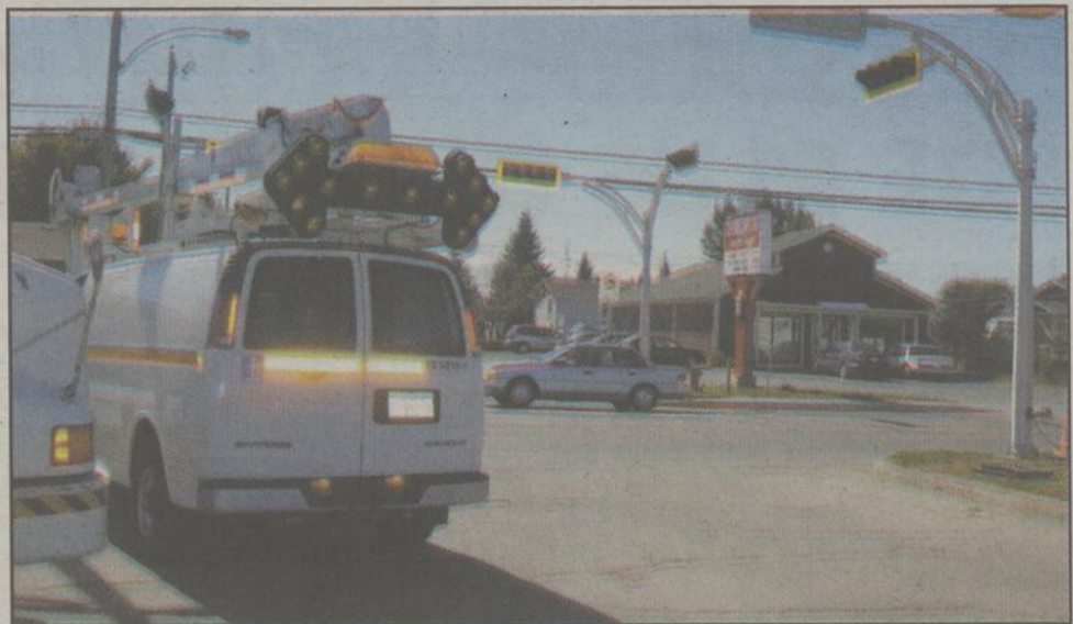
L'INSTALLATION A ÉTÉ réalisée en environ quatre heures.
