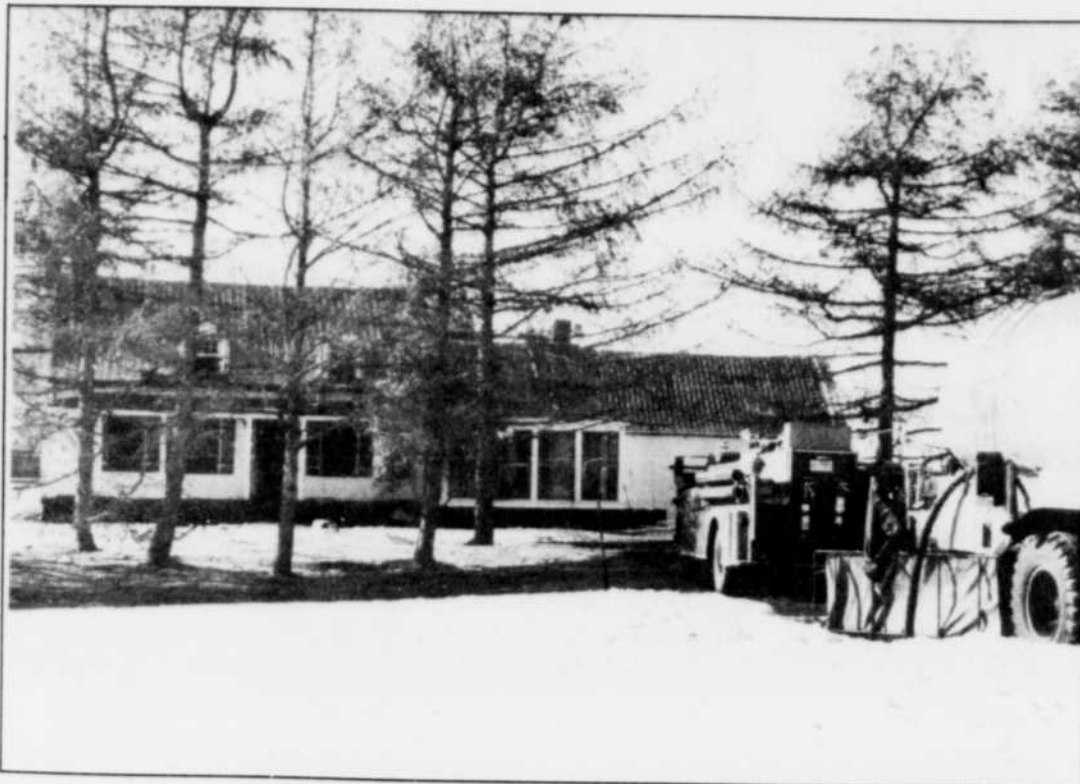
(Flageol Photo — Claude Deschesnes) Un incendie a lourdement endommagé l'intérieur de cette coquette maison du boulevard Sainte-Marguerite, à Saint-Maurice.
