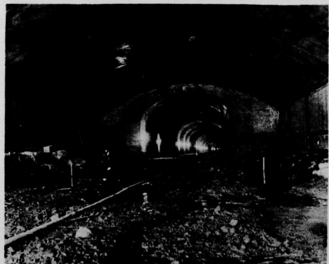
Sur une distance d'environ 500 pieds, la construction souterraine des stations du métro a nécessité à ces endroits un élargissement du tunnel, de 23 pieds à 44 pieds. Ci-dessus, la station Crémazie en bonne voie de parachèvement.
