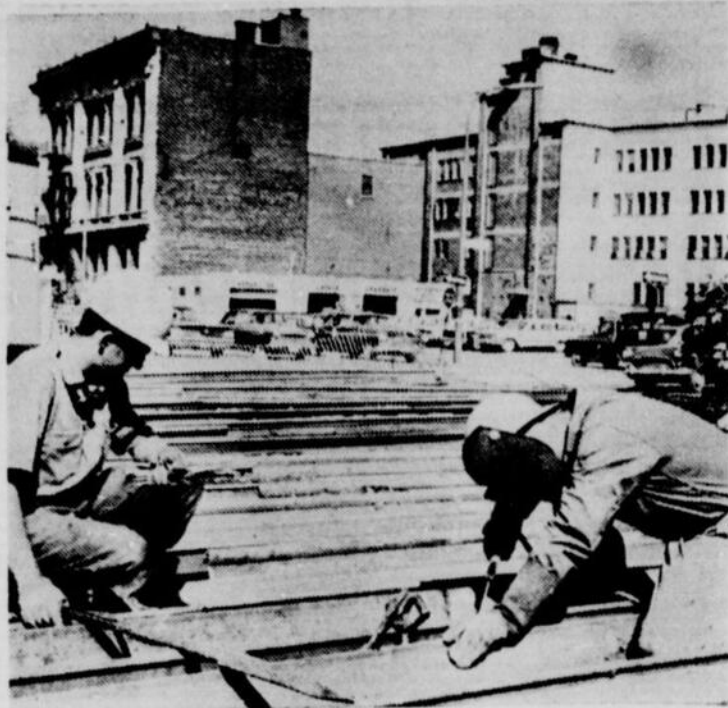
Rue de Vitré, des travaux de $890,000
