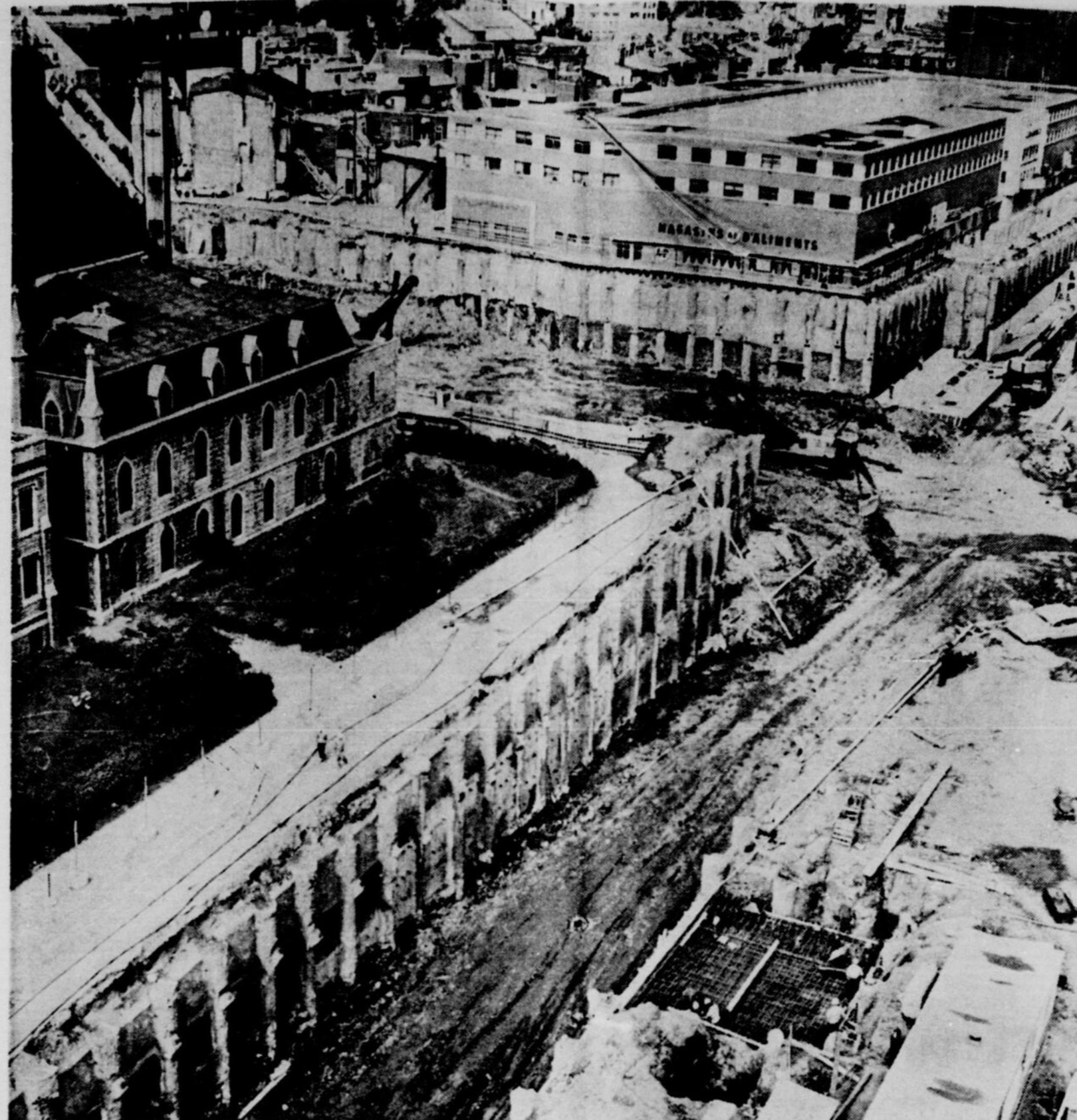
L'excavation, à l'angle des rues Berri et de Montigny. En bordure, on aperçoit les pieux de béton armé ancrés au roc par des tirants (sorte de contreforts enfouis sous terre). Les stations Berri-de Montigny sont les plus importantes du réseau. Les trains pivoteront autour de cet axe. Après les travaux de construction, le carrefour reprendra son aspect d'autrefois.
