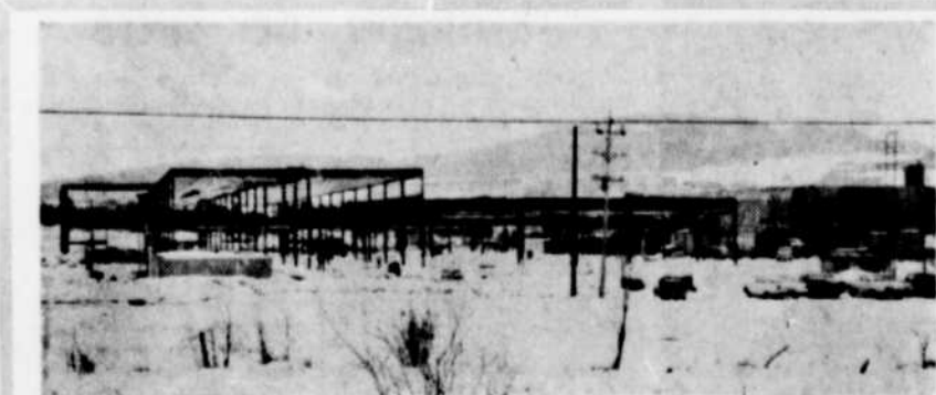
INSTITUT DE TECHNOLOGIE — Les travaux de construction de l'institut de technologie, situé dans le quartier ouest, se poursuivent rapidement. La bâtisse, construite au coût de $2,100,000, devrait être complétée en septembre. L'institut, qui relèvera du ministère de l'Éducation, pourra recevoir 1,000 élèves. (Photo La Tribune, par Studio Breton)
