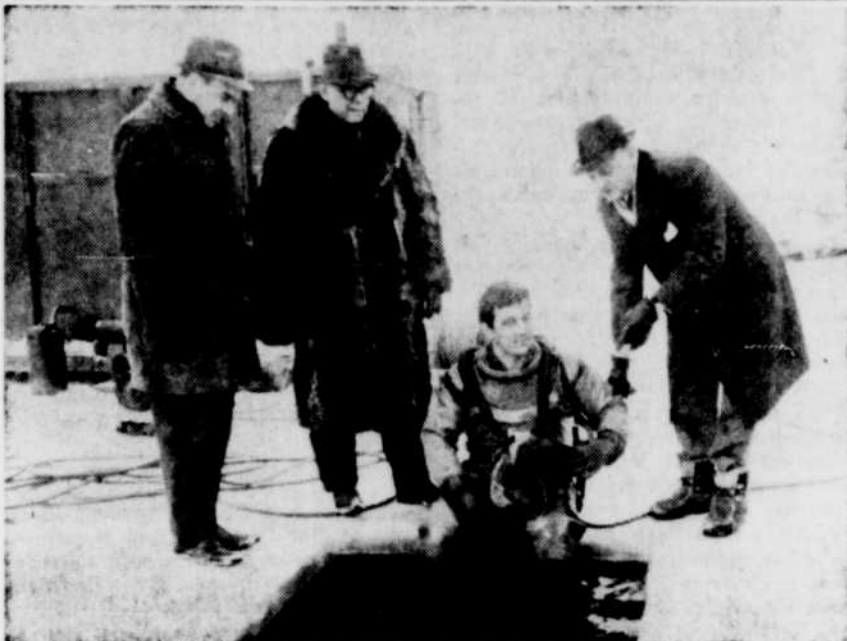
INSPECTION — Des plongeurs sont descendus dans le lac Memphrémagog pour inspecter l'endroit où sera installée la prise d'eau de la conduite d'adduction. Sur cette photo, M. Jacques Lemieux, ingénieur consultant, l'échevin J.-M. Jeanson, président de la commission d'aqueduc, un plongeur et le maire Armand Nadeau, c.r. (Photo La Tribune, par Studio Breton)
