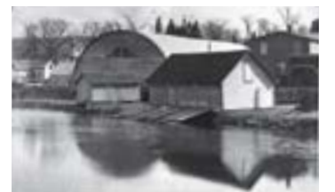
Aréna et hangar à bateau
