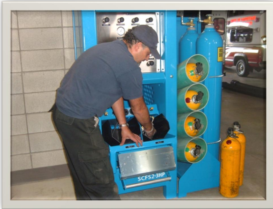
Test compresseur d'air
