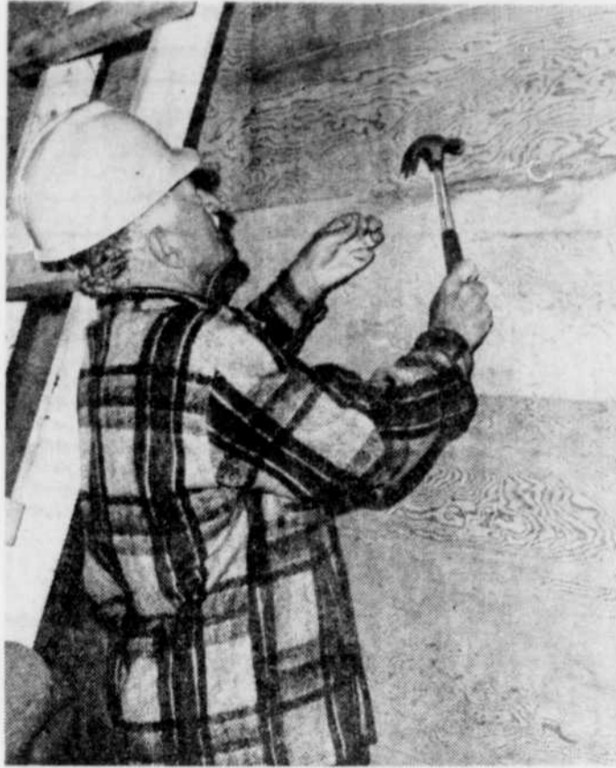
Revêtu d'une chemise à carreaux, M. Roland Michener a parcouru tout le chantier de construction, s'arrêtant même quelques instants pour planter des clous, dans un geste d'encouragement envers les travailleurs bénévoles.
