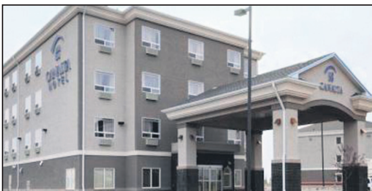
Les démarches vont bon train en vue de lancer les travaux de construction du nouvel hôtel au cours de l'automne.
