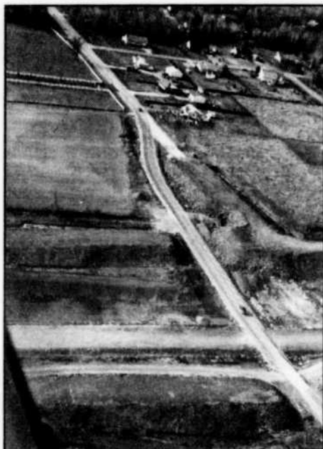
Sans tambours ni trompettes, les travaux de l'autoroute 50 vont bon train, comme le démontre cette photo aérienne du chantier. Photo: Yannick Boursier
