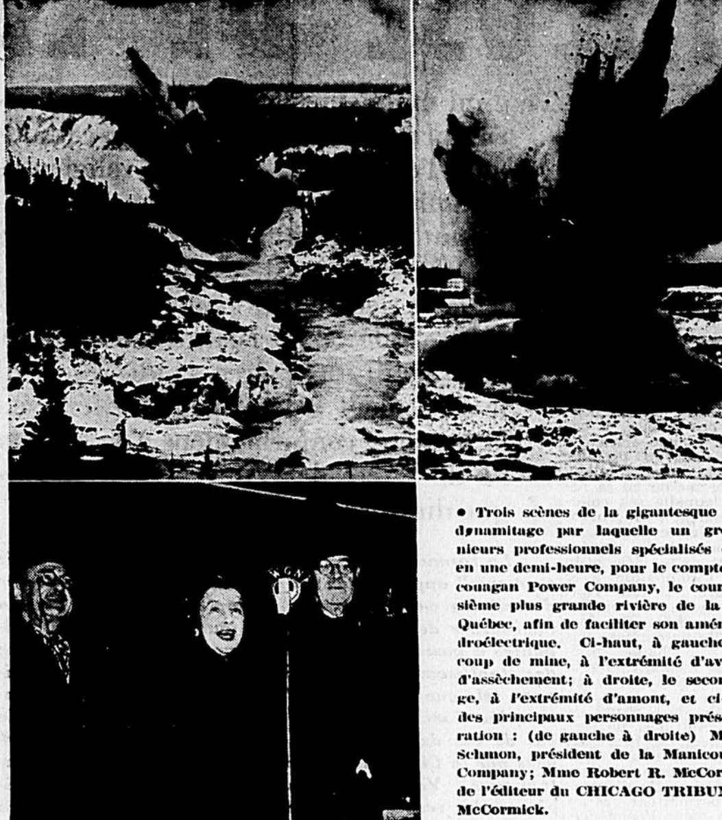
• Trois scènes de la gigantesque opération de dynamitage par laquelle un groupe d'ingénieurs professionnels spécialisés ont déterrés en une demi-heure, pour le compte de la Manicouagan Power Company, le cours de la troisième plus grande rivière de la province de Québec, afin de faciliter son aménagement hydroélectrique. Ci-haut, à gauche, le premier coup de mine, à l'extrémité d'aval du tunnel d'assèchement; à droite, le second dynamitage; à l'extrémité d'amont, et ci-contre, trois des principaux personnages présents à l'opération: (de gauche à droite) M. Arthur A. Schuman, président de la Manicouagan Power Company; Mme Robert R. McCormick, épouse de l'éditeur du CHICAGO TRIBUNE, et le Col. McCormick.
