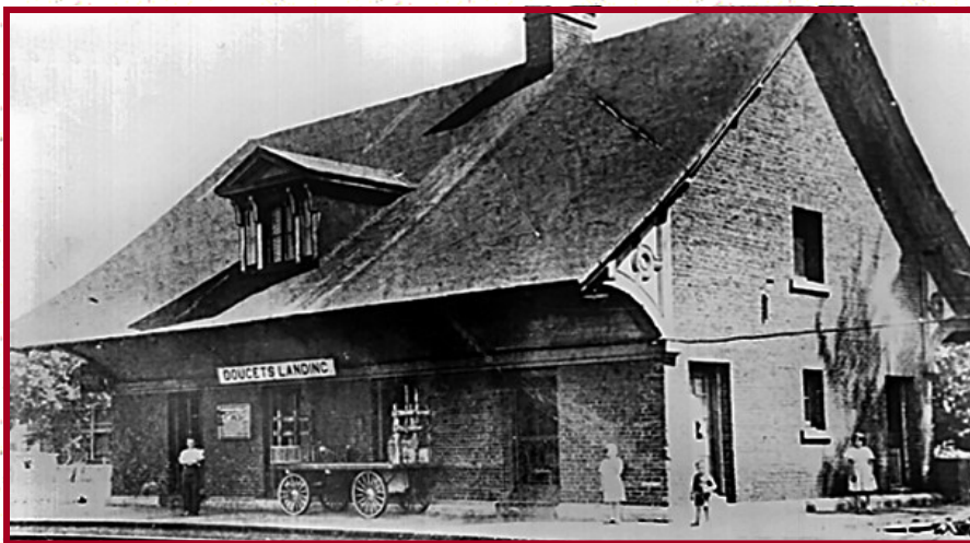
Gare de Sainte-Angèle-de-Laval, appelée à l'époque Doucet's Landing. (Auteur inconnu)
