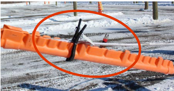
Conducteur à nu à cause d'un protecteur mal fixé
