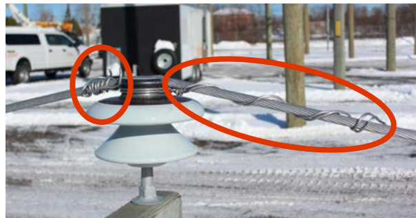
Relâchement des fils d'attache
