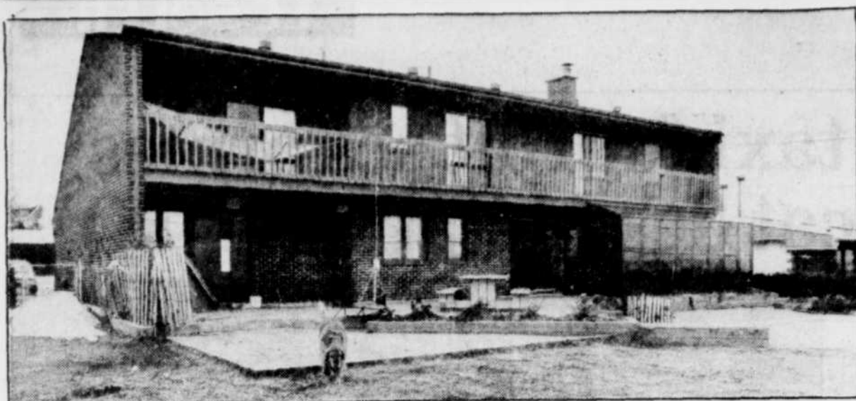
La maison de M. Jean-Luc Roy, sur le terrain ayant servi de dépôt.
