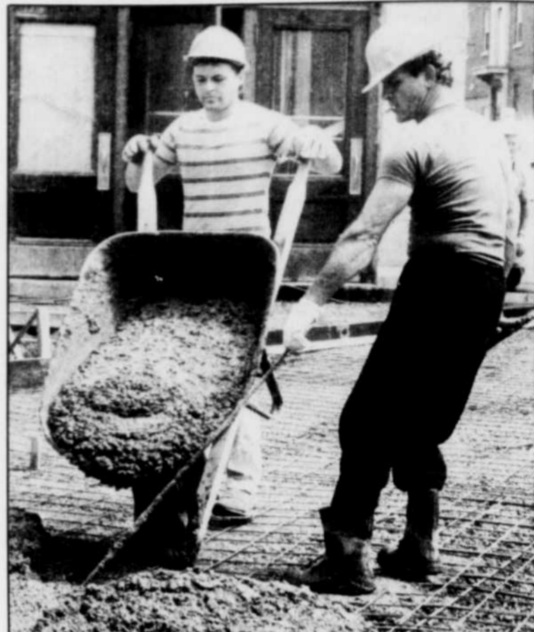
Quelques ouvriers s'adonnaient, hier, à couler du béton dans une aire de débarquement. (Flageol Photo — Claude Deschesnes)
