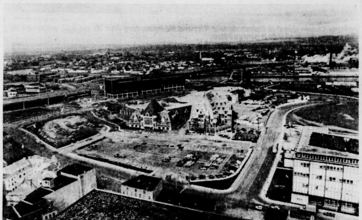
Après une longue période d'inactivité, la gare du Palais redevient l'élément moteur du développement du centre-ville de Québec.
