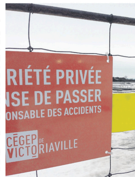
De la rue Croteau, on peut voir les fondations de la station de recherche du cégep de Victoriaville. (Photo TC Media – Hélène Ruel)
