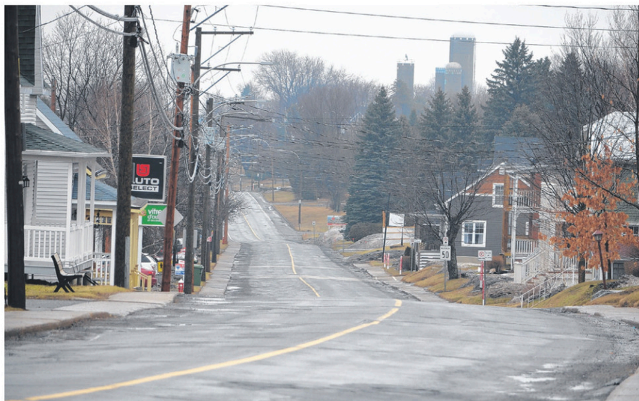
Warwick mènera un gros chantier de réfection des canalisations sur un segment de la rue Saint-Louis. (Photo TC Media - Hélène Ruel)
