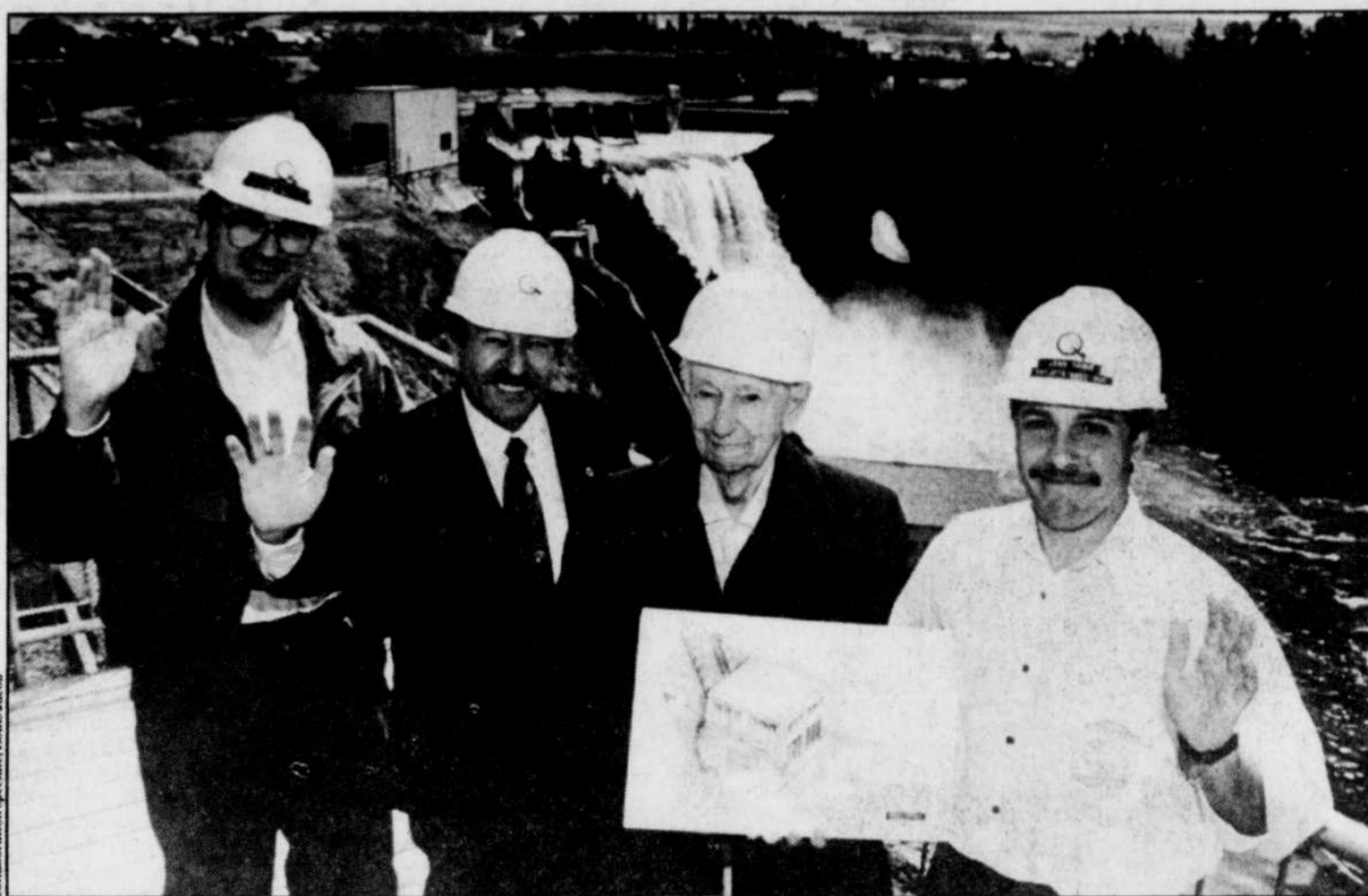
Hydro-Québec, région Matapédia, a conservé intact sur une période de 70 ans le patrimoine technologique du Bas-Saint-Laurent que constitue la centrale hydraulique Mitis 1. Sur la photo : Steve Hamilton, responsable des travaux mécaniques et électriques, Alphonse Fournier, de l'équipe des pionniers de Mitis 1, Christian Girard, chef de la division clientèle et information à Hydro-Québec, région Matapédia, et Jean Gagné, responsable des travaux civils à Mitis 1.
