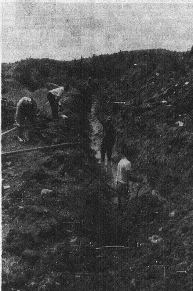
On a creusé une tranchée de 2,200 pieds...
