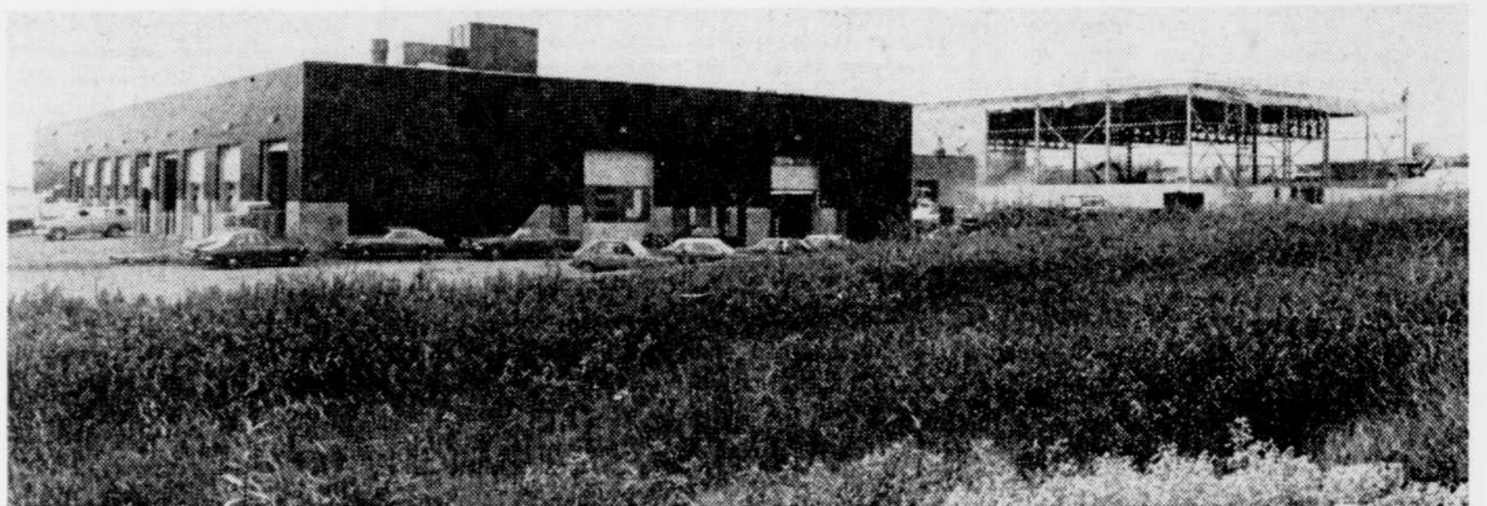
Le garage municipal, phase 1, a coûté $2,050,000 tandis que la phase 2 en construction nécessitera des fonds de $820,000.
