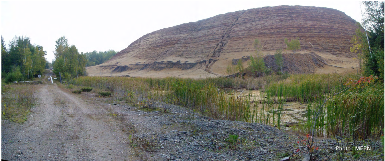
Parc à résidus B de l'ancienne mine New Calumet.
