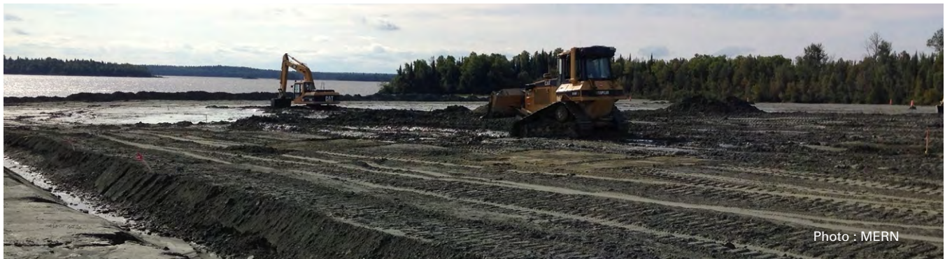
Mise en place du recouvrement granulaire sur le parc à résidus Siscoe.
