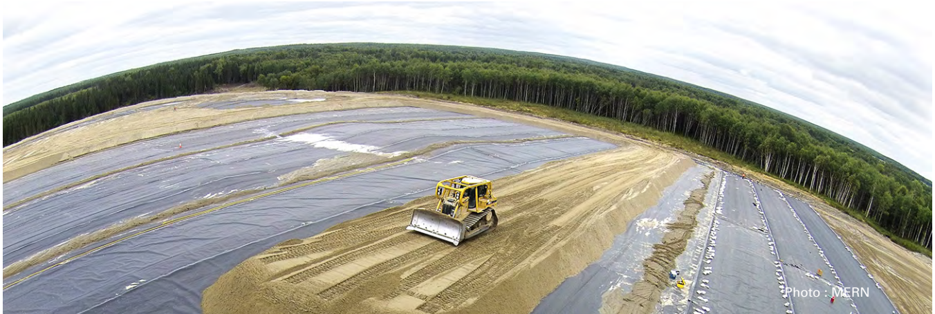
Mise en place de la géomembrane à Barvue.
