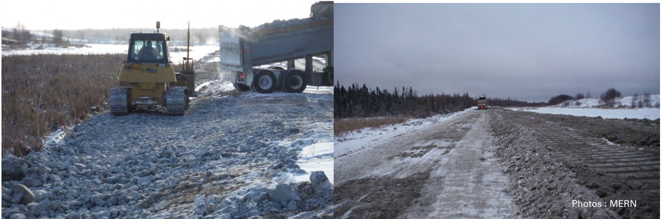
Construction de la berme de stabilisation à l'intérieur de la digue Ouest.
