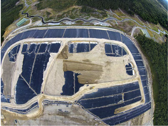
Travaux de confinement du parc à résidus Barvue.
