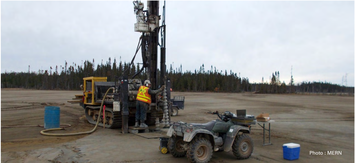
Travaux de caractérisation complémentaire à Mine Principale.
