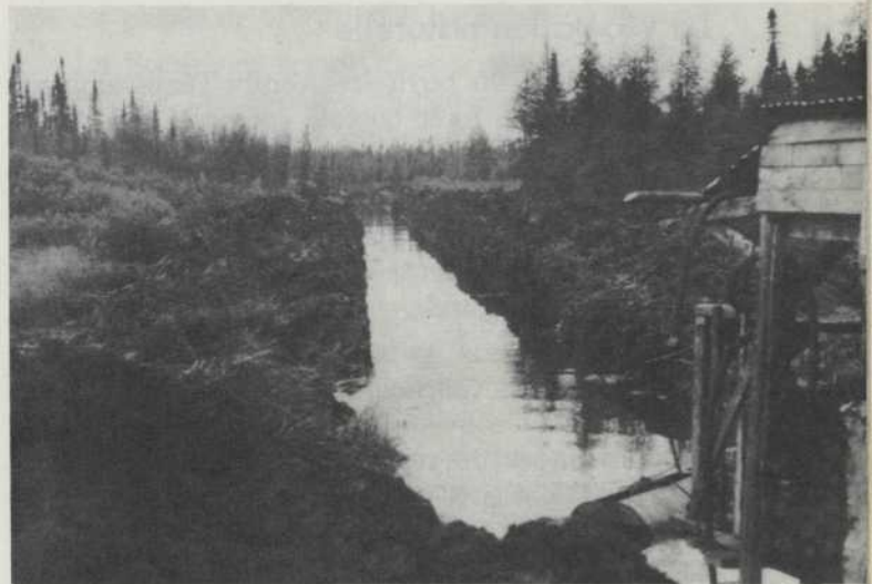
Travaux de drainage exécutés pour le compte du ministère de l'Agriculture et de la Colonisation, dans le canton Rousseau, en Abitibi.
