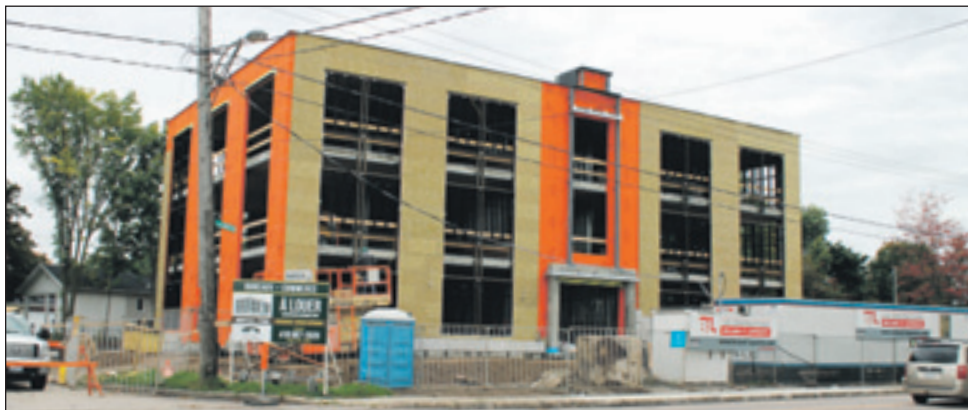
L'édifice accueillera le siège social de Gestion immobilière Gescorp au 3325, Chemin Sainte-Foy.
