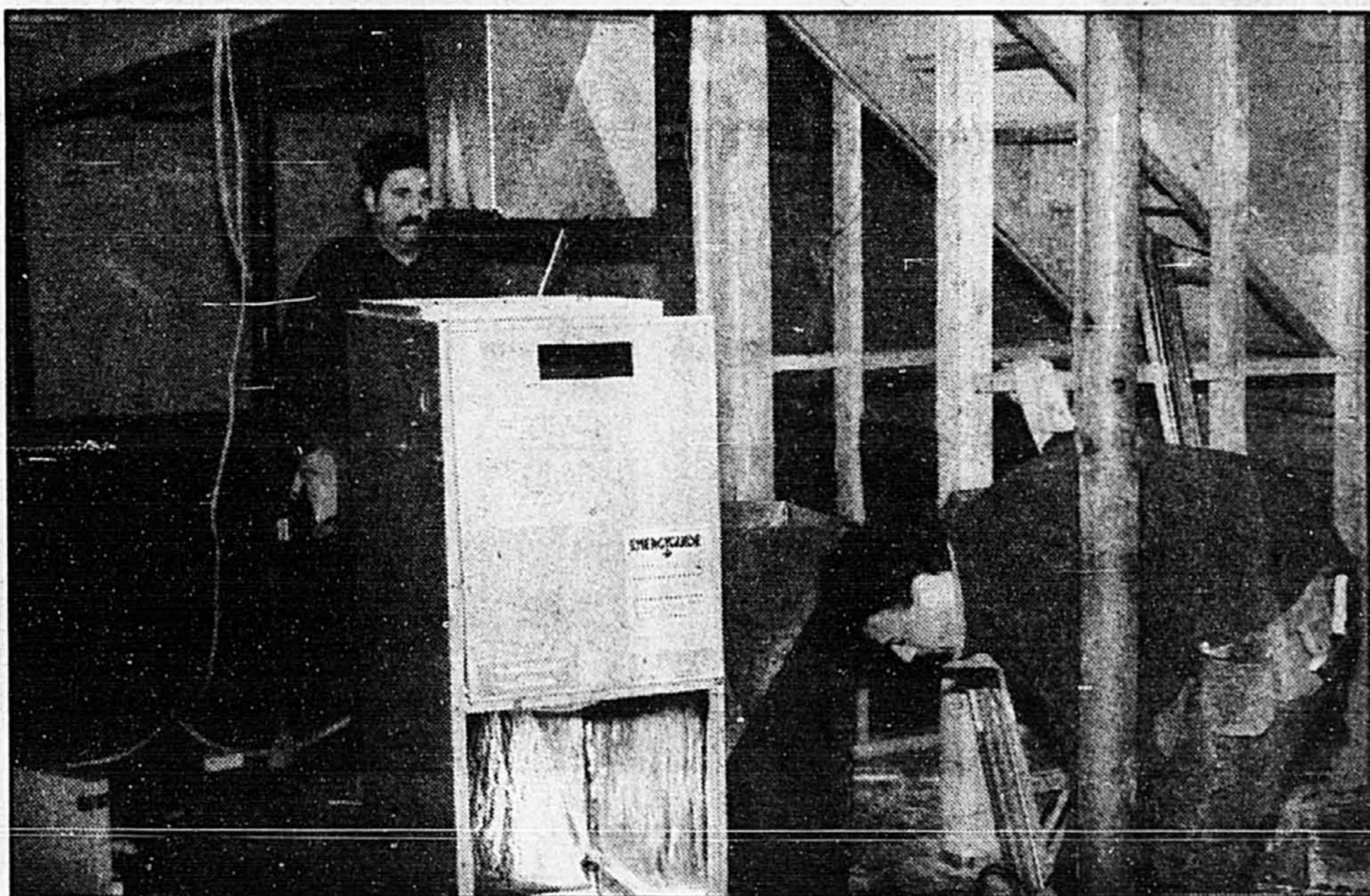
M. Legault (à gauche) et Daniel Hébert achèvent de compléter la mise en place du système de chauffage. Le filtre électronique sera disposé dans la partie inférieure de la fournaise.
