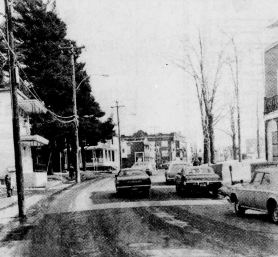
Cette courbe de la rue Notre-Dame ouest près du rond-point au centre-ville a pris plusieurs automobilistes par surprise et les poteaux que l'on aperçoit à gauche et au centre de la photo ont souvent été la cible de ces automobilistes. La fin de semaine dernière encore... de telle sorte que le conseiller Gaston Dunn a cru bon de proposer qu'une étude soit entreprise sur les possibilités d'enlever les poteaux ou d'amoinrir l'angle de la courbe lors de la dernière réunion régulière du conseil municipal. (Photo La Tribune, Victoriaville, Serge Beaucher)
