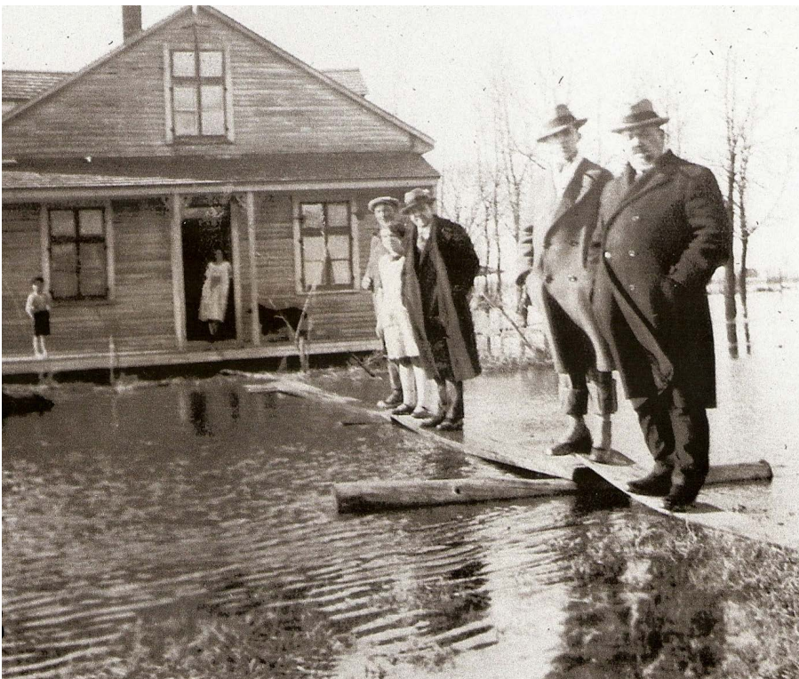
L'inondation de 1928 à RDP
