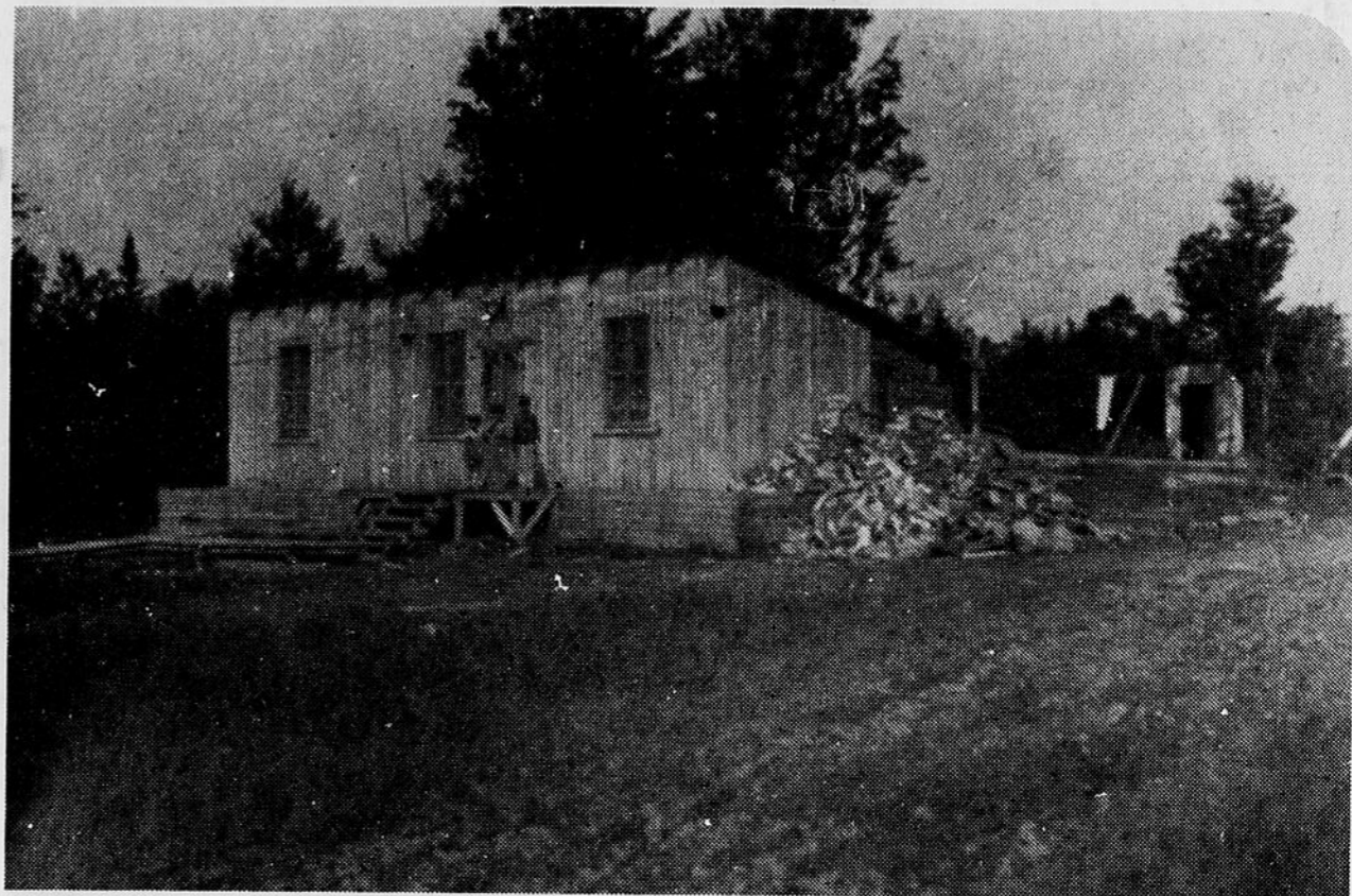
1925 — Cette première maison privée à Arvida fut construite en 1925. Elle appartenait à un dénommé John Boyl.
