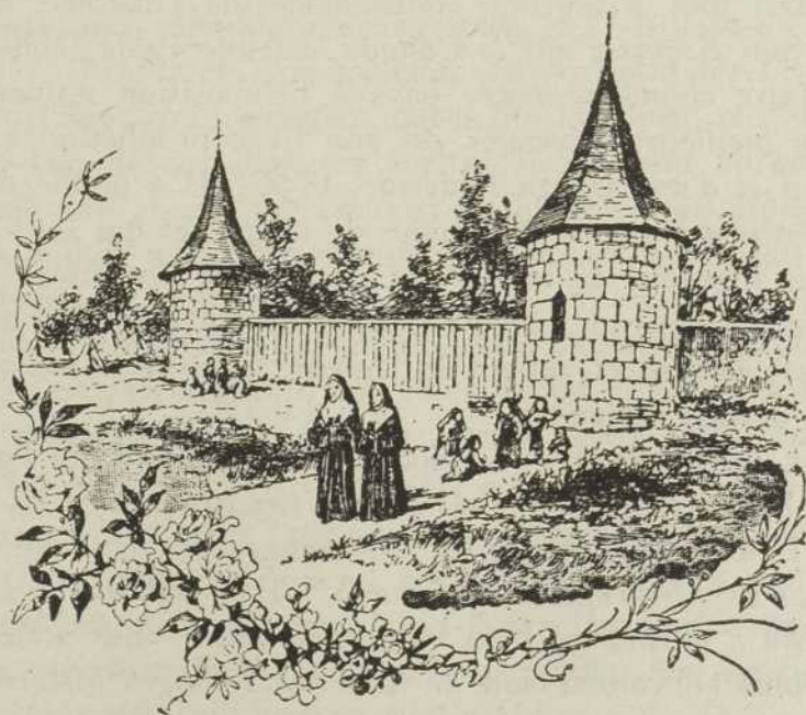
Les tours du fort de la Montagne
