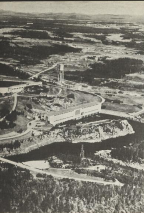
Centrale hydroélectrique de Shipshaw.
